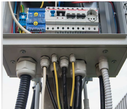
Герметизация кабеля СИП
