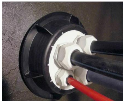
Герметизация кабеля СИП
