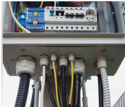
Герметизация кабеля СИП
